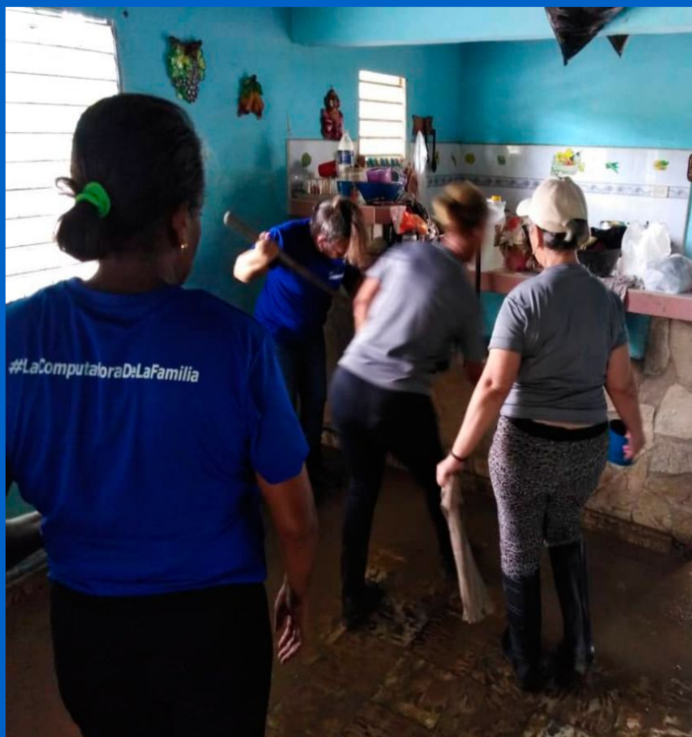
Fig. 1. Trabajadores de los Joven Club ayudando en la recuperación de los daños causados por Oscar
